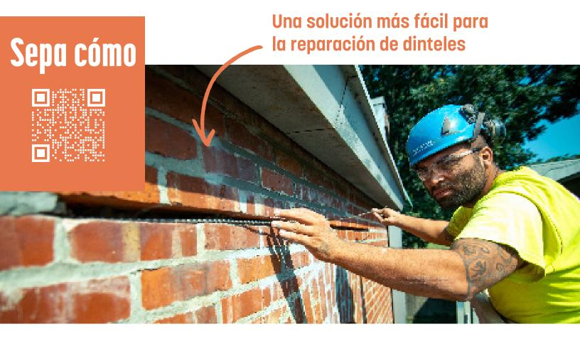
En conjunto con SureGrout S, la barra de amarre Stitch-Tie de PROSOCO refuerza áreas de mampostería y produce vigas de ladrillo compuestas, lo que permite que la mampostería se extienda sobre aberturas. En construcciones de varios hilos, el refuerzo helicoidal puede ser fortalecido aún más si se instala en los hilos interiores y exteriores.
